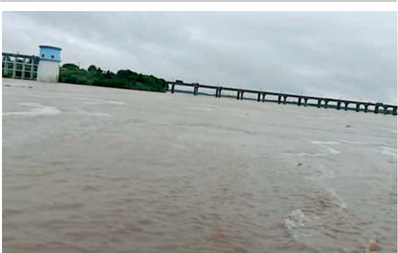
గురువారం భద్రాచలం వద్ద ఉధృతంగా వరద గోదావరి
